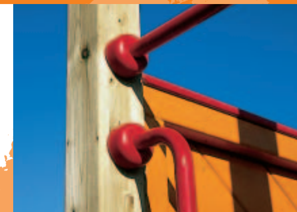
Der „HEGE“-Knopf befestigt Griffstangen und Wandelemente vandalismussicher, da keine Schraubenverbindung mehr zu sehen ist.
