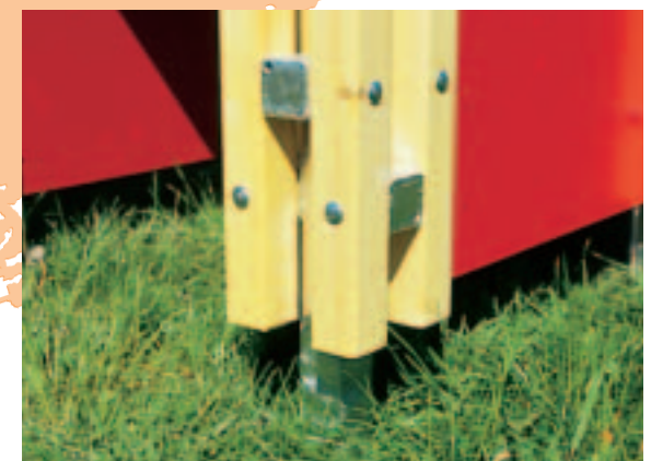
Standpfosten aus 4 kerngetrennten Fichtekanthölzern, lasiert mit Spezialpfostenschuh
