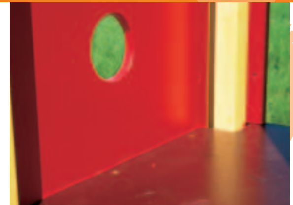
Bodenteile aus 21mm starken Siebdruckplatten
