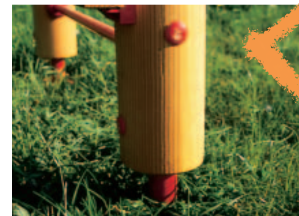
Kernfreie Douglasienhölzer, unimprägiert mit Öl-Lasur, 14cm Durchmesser. Mit eingebohrtem Pfostenschuh.
